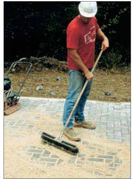
Fugegrus fejes i fugerne inden første vibrering.
